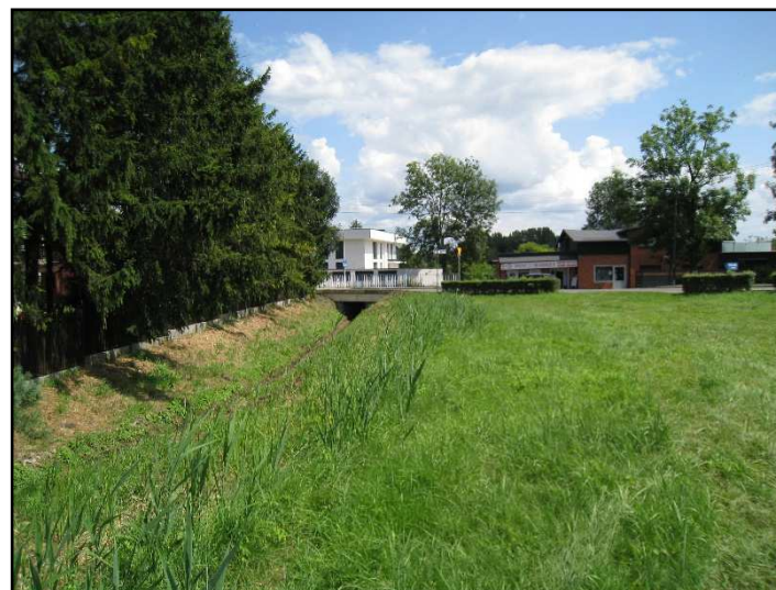
Fot. 28 Imielinka w rejonie ul. Brata Alberta
