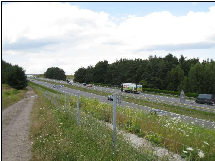
Fot. 42 Autostrada A4, widok ze wzgórza przy ul. Satelickiej
