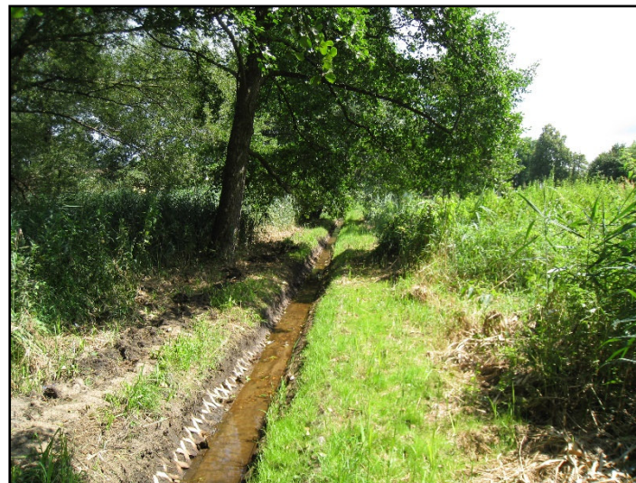
Fot. 24 Imielinka w rejonie ul. Brata Alberta
