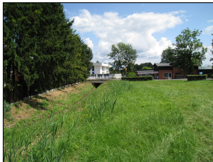
Fot. 28 Imielinka w rejonie ul. Brata Alberta
