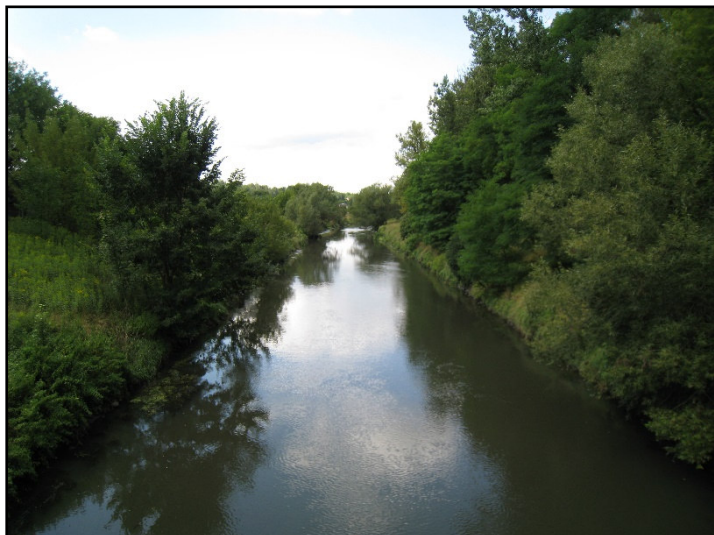
Fot. 46 Biała Przemsza, widok z mostu na ul. Długiej, widok w kierunku północnym
