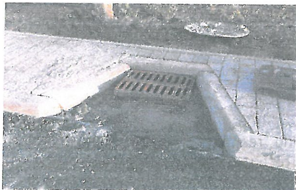
Studzienka w „poboczu utwardzonym” przed asfaltowaniem jezdni. Fot. E.Szymańska Sułkowska.
