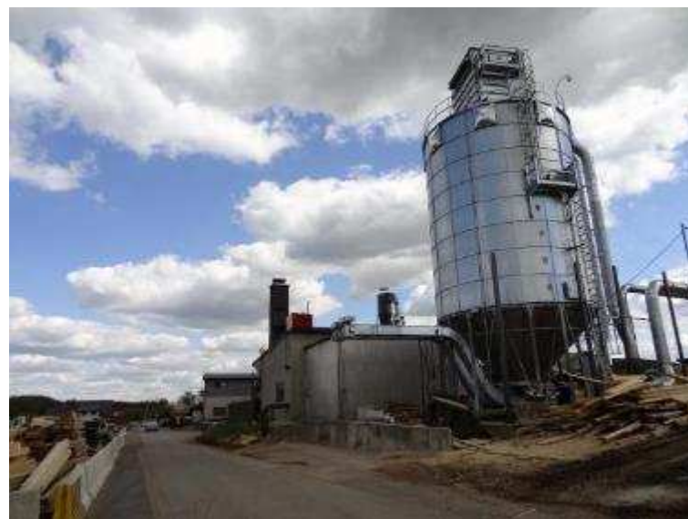
Fot. 9 Widok na Tartak Imielin w północnej części obszaru planu.
